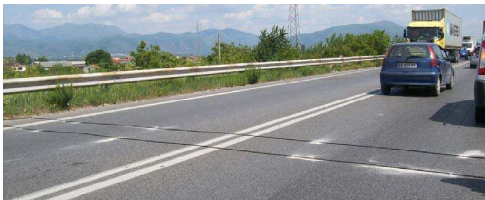
FIGURA 2 – ESEMPIO DI POSA DI UN ANALIZZATORE DI TRAFFICO A TUBI PNEUMATICI
